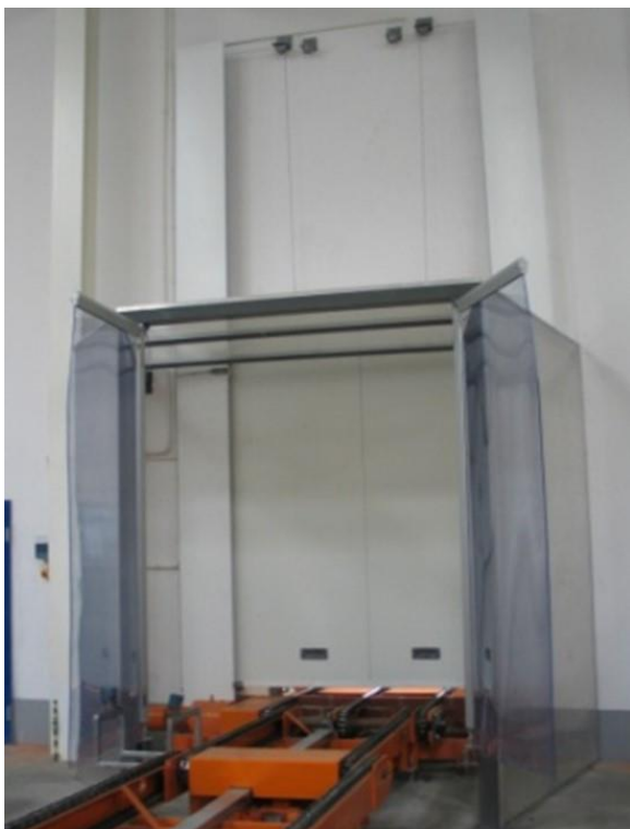
Fot.6. Brama opuszczana MARC-O EI 60, transporter łańcuchowy. Widoczne pod bramą stałe uszczelnienie ppoż. klasy EI 120.
