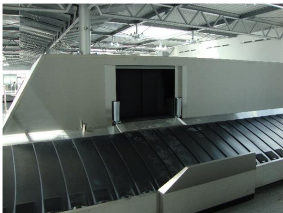
Fot. 5. Gródź przeciwpożarowa dostosowana do systemu taśm transportowych na lotnisku, Poznań Ławica
