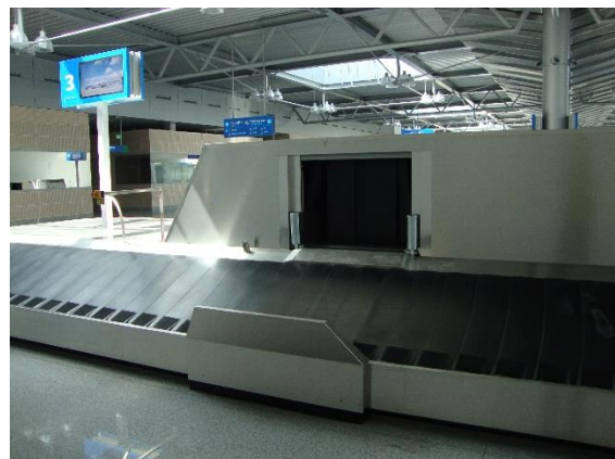
Fot. 5. Gródź przeciwpożarowa dostosowana do systemu taśm transportowych na lotnisku, Poznań Ławica
