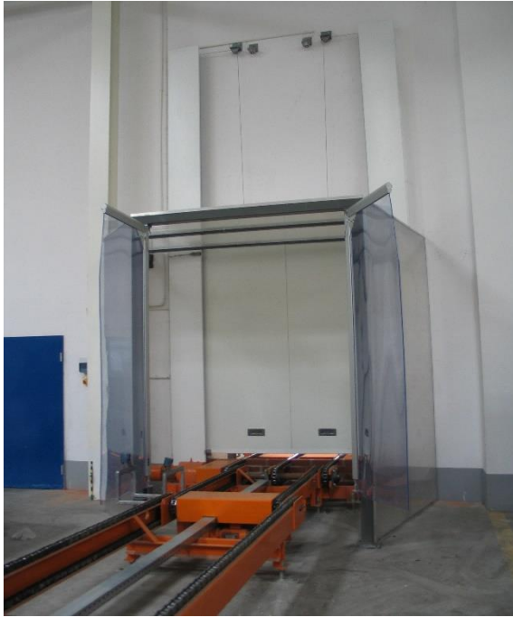
Fot. 3 i 4. Przejścia transportowe zabezpieczone przeciwpożarowo na drodze taśmociągów w zakładach przemysłowych
