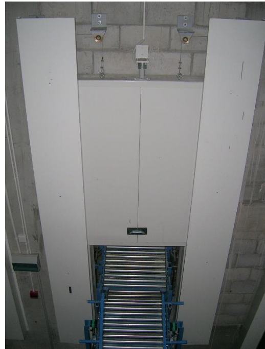
Fot. 3 i 4. Przejścia transportowe zabezpieczone przeciwpożarowo na drodze taśmociągów w zakładach przemysłowych
