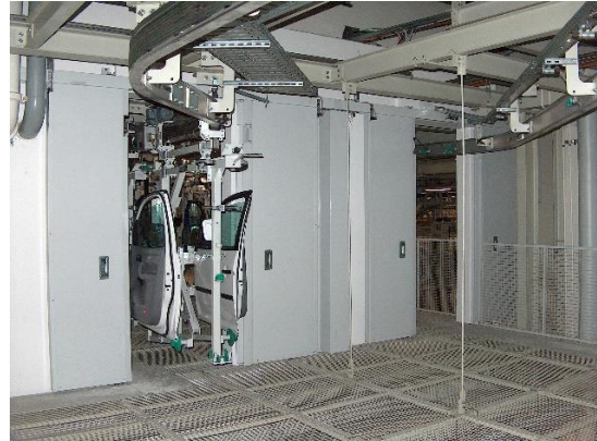
Fot.1 i 2. Grodzie przeciwpożarowe firmy Małkowski-Martech S.A. na drodze taśmociągów, Fabryka Samochodów Volkswagen
