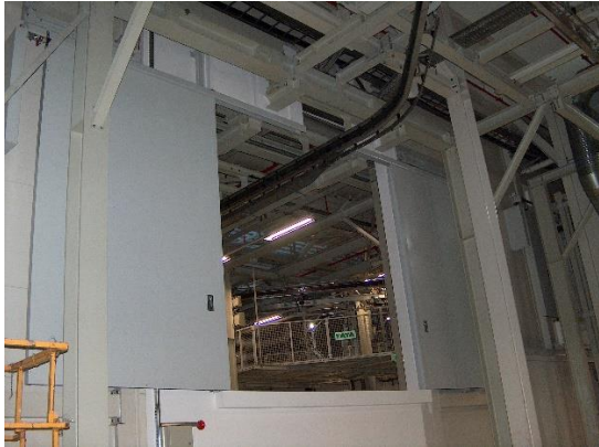
Fot.1 i 2. Grodzie przeciwpożarowe firmy Małkowski-Martech S.A. na drodze taśmociągów, Fabryka Samochodów Volkswagen
