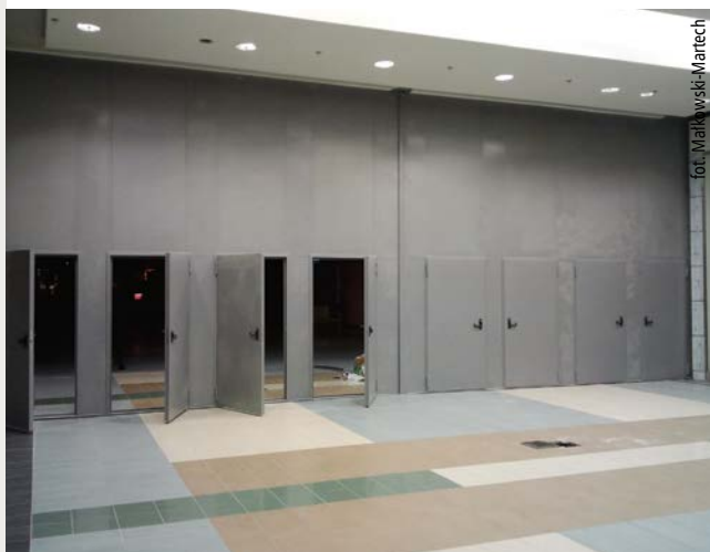
Fot. 5. Brama rozsuwana klasy EI-120 z ośmioma drzwiami EI-60
